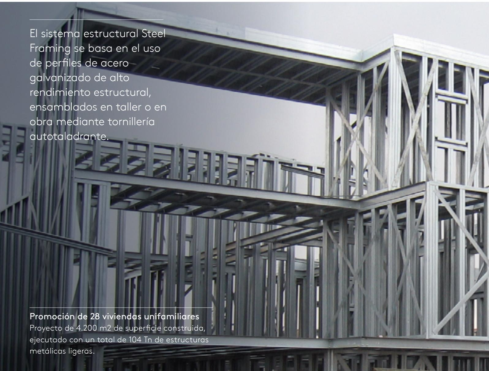
El sistema estructural Steel Framing se basa en el uso de perfiles de acero galvanizado de alto rendimiento estructural, ensamblados en taller o en obra mediante tornillería autotaladrante.
